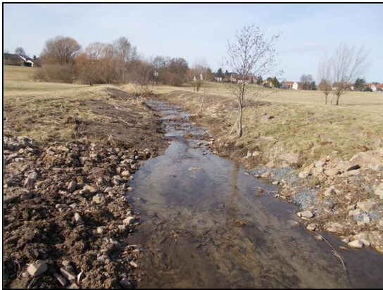
Abb. 6: nach der Maßnahme: Sedimentberäumung oberhalb Sedimentfang, 04.04.2018
