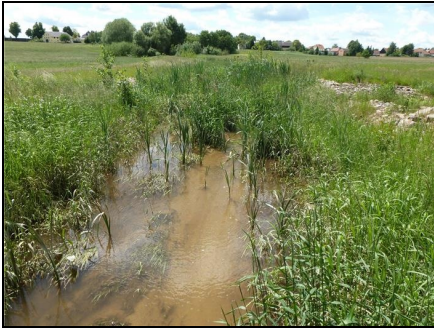
Abb. 2: vor der Maßnahme: Sedimentablagerungen vor Drossel- und Verteilerbauwerk, 11.06.2013
