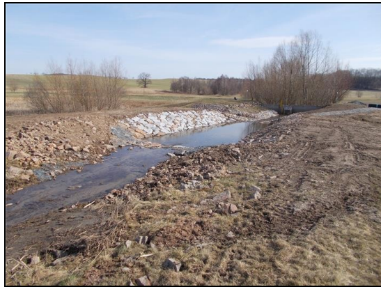
Abb. 7: nach der Maßnahme: Neu angelegter Sedimentfang vor Drosselbauwerk, Blick stromab, 04.04.2018
