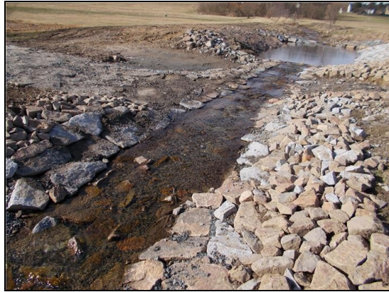
Abb. 5: nach der Maßnahme: Abschnitt vor Drosselbauwerk, Blick stromauf, 04.04.2018
